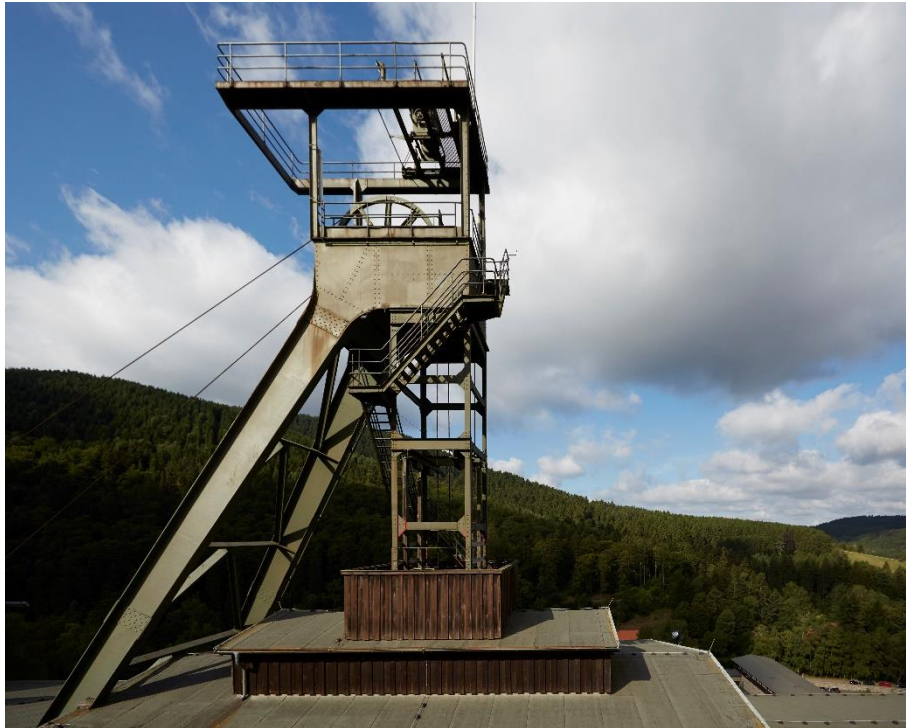
Weithin sichtbares Zeichen für den Bergbau: Fördergerüst in Kastenbauweise über dem Rammelsberg-Schacht des Erzbergwerks Rammelsberg, erbaut 1937/38.
