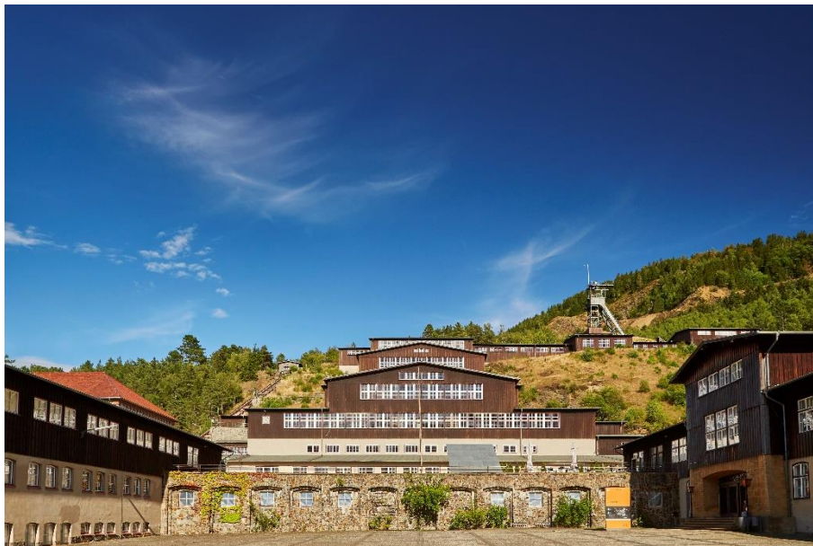
Industriedenkmal mit UNESCO-Welterbestatus: Das ehemalige Bergwerk Rammelsberg © Stefan Sobotta
